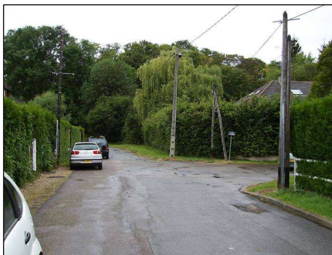
Photo 7 : Réseau d'évacuation des eaux au lotissement « le Pré-Saint-Vandril »
